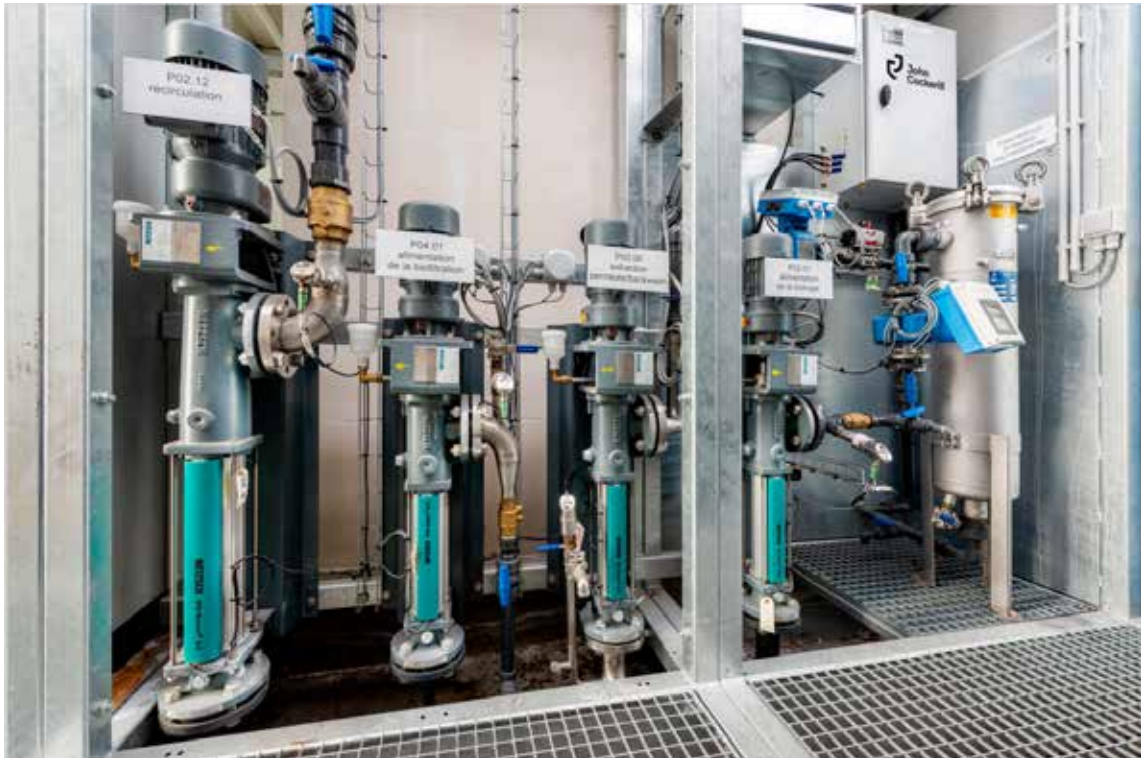
FIGURE 2. POMPES D'ALIMENTATION ET DE TRANSFERT ENTRE CUVES DE L'INSTALLATION PILOTE MEDIX EN EXPLOITATION À LA CLINIQUE SAINT-PIERRE D'OTTIGNIES
